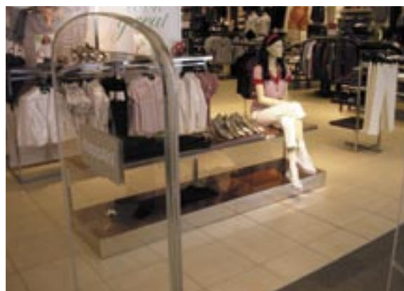
Installasjonsbehandlet granitkeramikkgulv, KappAhl
